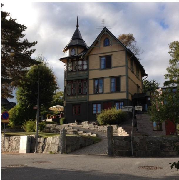
Bild 1. Högt beläget hus med torn i korsningen Villavägen/ Ringvägen, ca 50 meter från planområdet.
