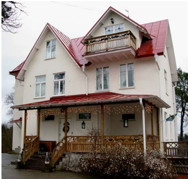
Bild 3. Fjärilen 15. Entré samt takkupa med balkong sedd från Örnstigen.
