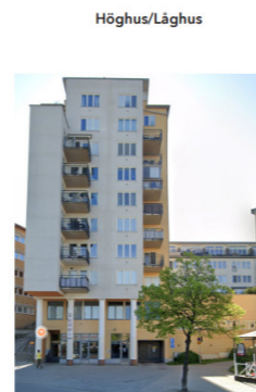
Höghus/Läghus Höghus och sockel på Kavalleriägen 20: Murad tegelsocken, målade volymer i gul och grå/vitt kulör, flacka tak, ljusa fönster- och dörrkarmar och mötposter, arkadgång som förstärker den vertikala riktningen
