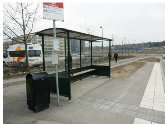
Figur 16 Busshållplatserna är tillgänglighetsanpassade med taktil och kontrastmarkerad beläggning och sittplatser. Väderskydd finns på både Gesällvägen och Rissneleden.
