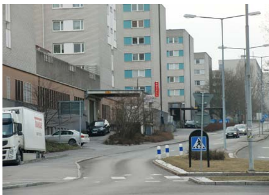
Figur 5 Södra sidan med storskaliga bostadshus med verksamheter i bottenplan.
