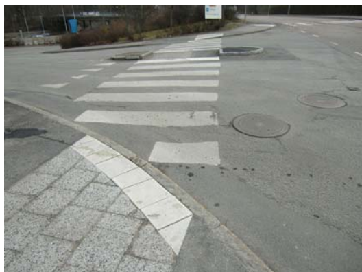
Figur 15 I närområdet till samt längs med Rissneleden har tillgänglighetsanpassade åtgärder gjorts, dock med varierat resultat. Övanstående leder blinda åt höger ut i gatan istället för över övergångsstället.
