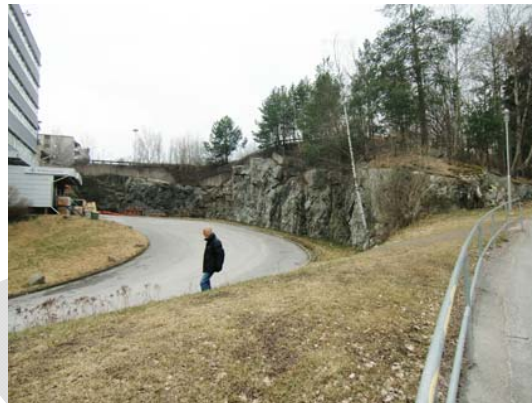
Figur 8 Schakt för att möjliggöra varutransport till fastigheten.
