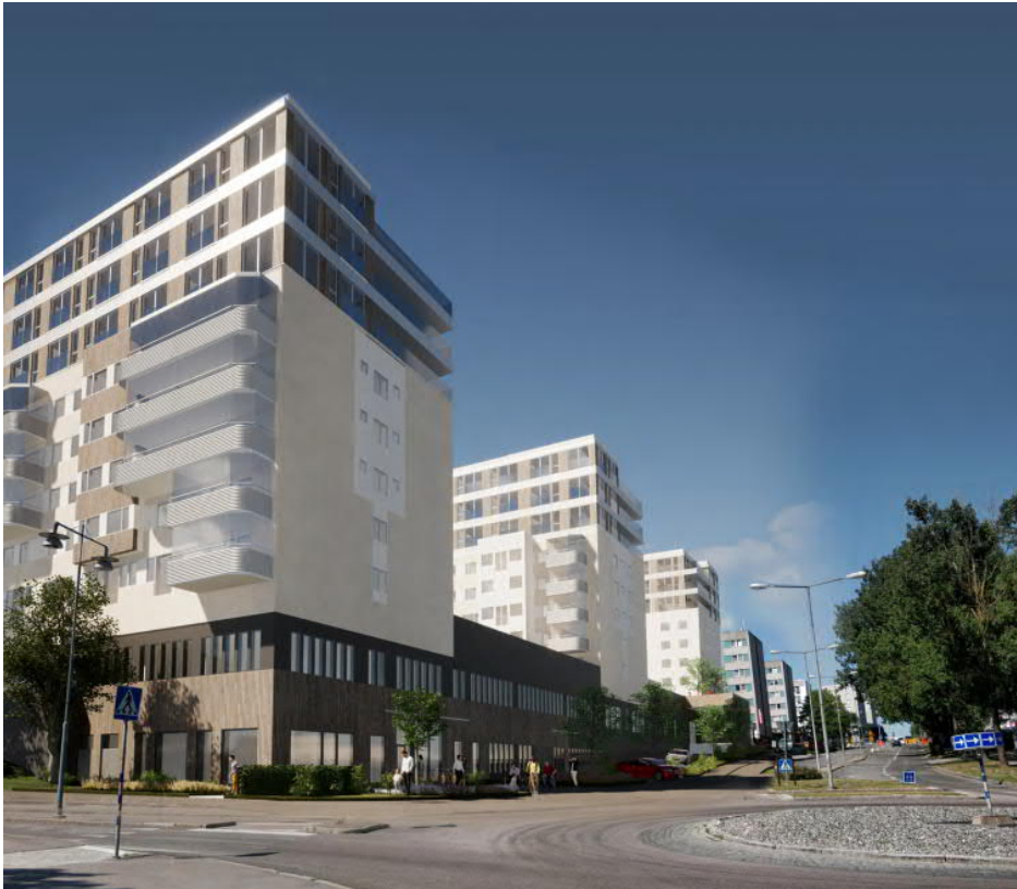
Figur 2. Vy från öster, Rissneleden.(underlag 2020-07-17) tillhandahållen av beställaren.
