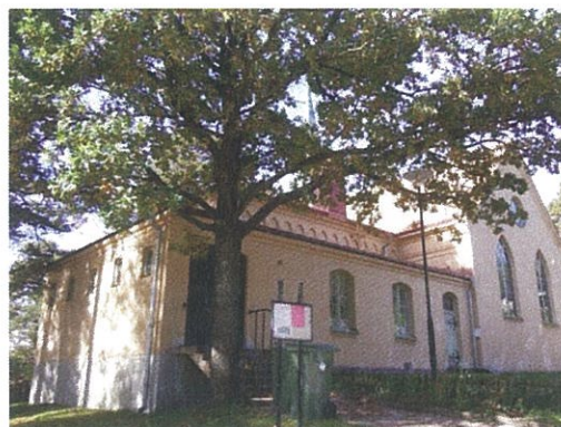
Den östra fasaden med församlingssal
