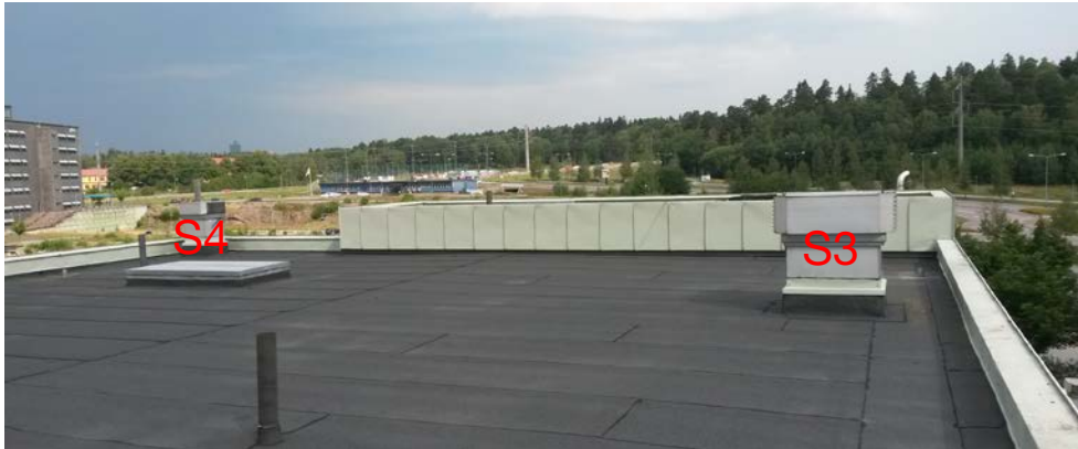
Figur 4. Källa S3 och S4, avluftshuvar. Planerad bebyggelse till vänster om bild.
