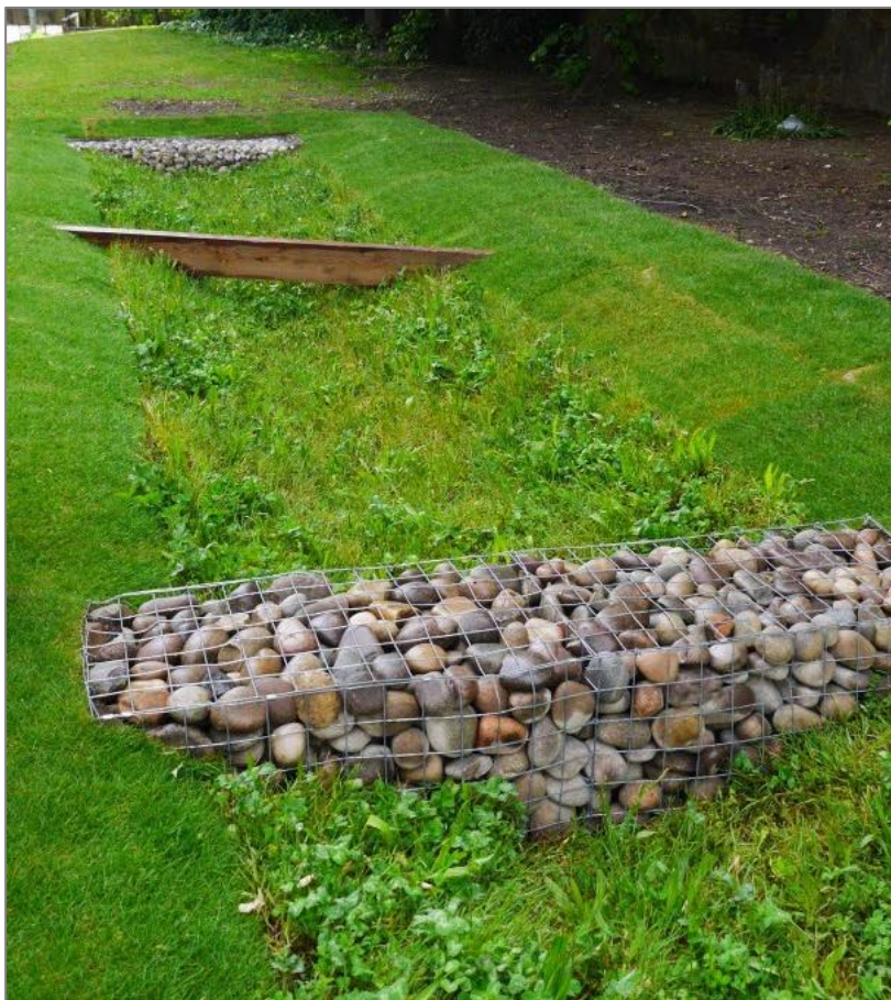
Figur 6-2. Exempel ett svackdike med dämnen.
