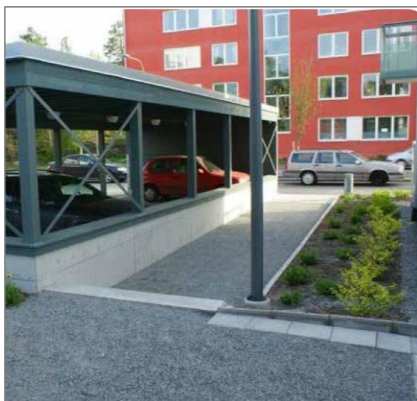
Figur 6-4. Exempel på genomsläpplig beläggning i form av grus (Uppsala Vatten, 2014).
