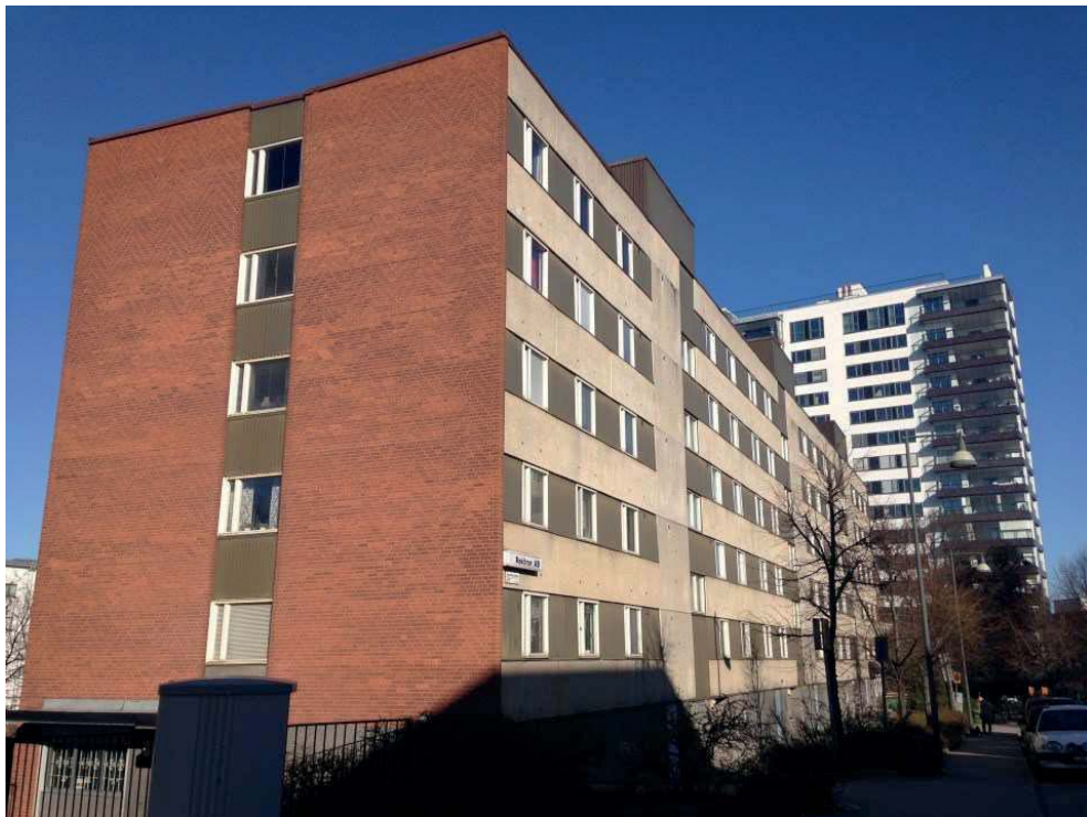
Bild 2: Byggnaden sedd från Franstorpsvägen.
