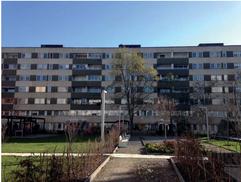
Bild 1: Befintligt bostadsbus sett från gården.
