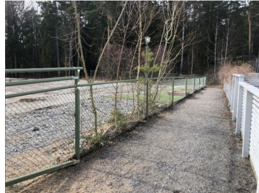
Bilden visar passagen mellan förskolan och bostadsområdet. Passagen ska breddas till 3,5 meter (Sundbyberg stad).
