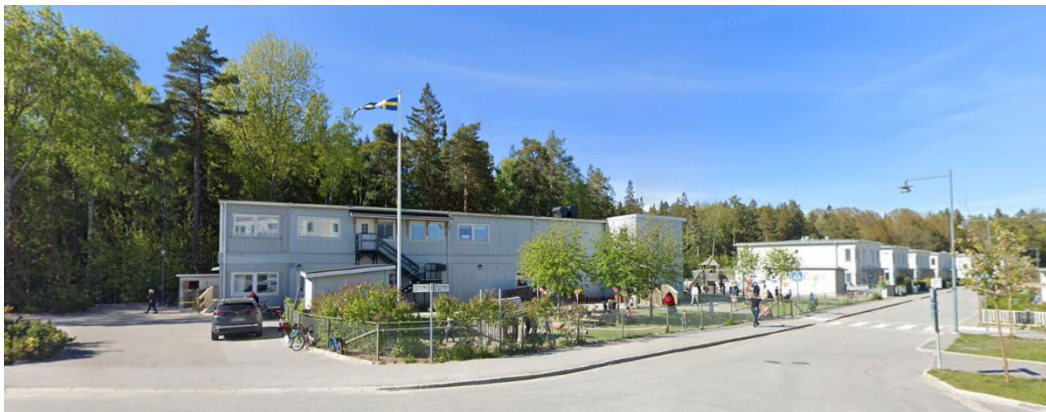
Den provisoriska förskolan (2021), vy från Stövarvägen (Google maps).
