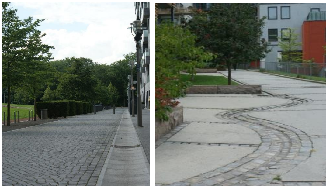
Figur 15 – Exempel på rännor i kombination med permeabel beläggning (Bild: Sweco).
