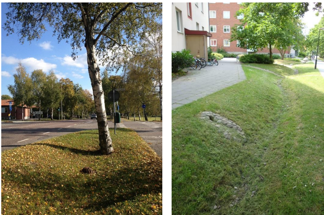
Figur 17 - Exempel på utformning av svackdiken (Bild: Sweco)
