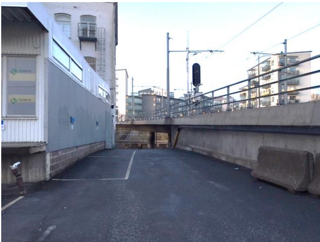
Figur 4. Foto taget från fastighetens nuvarande parkering i sydvästlig riktning med Tvärbanans spår till höger i bild. Källa: Briab.
