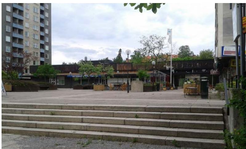
Bild 2. Byggnad vilken planeras inrymma förskola. Fasad mot söder (Tuletorget).
