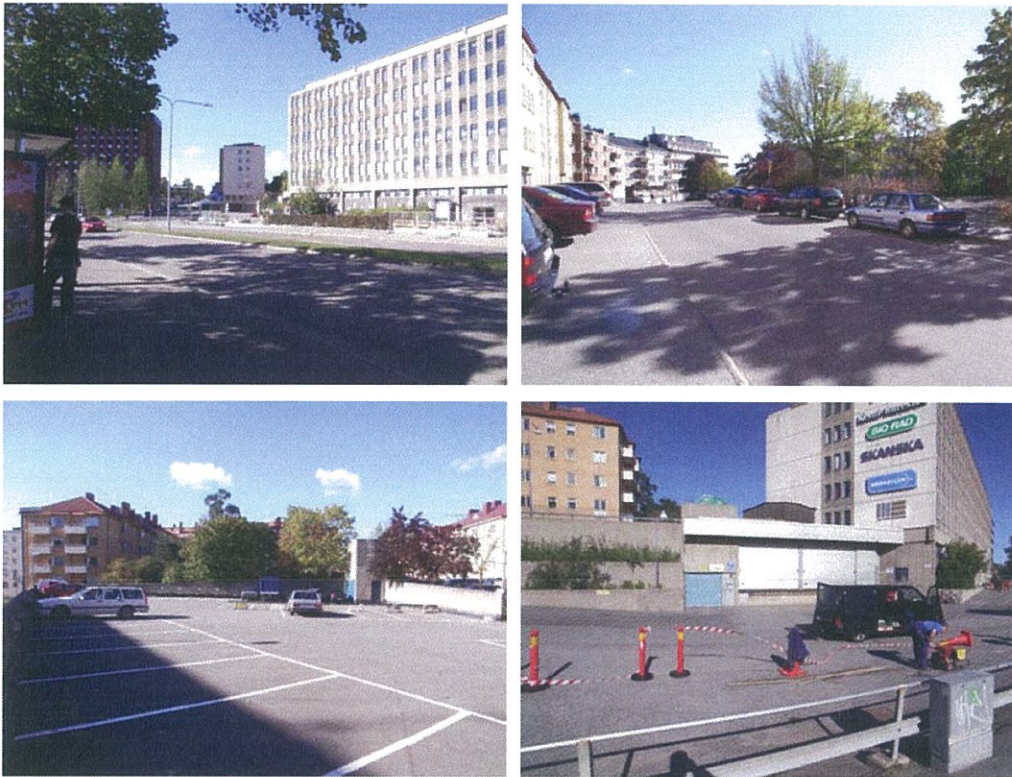
Ovan: T.v. befintlig kontorsbyggnad. T.h. vy utmed Vintergatan. Nedan: T.v. parkeringsdäck på befintlig lagerbyggnad. T.h. platsen där det nya punkthuset planeras.
